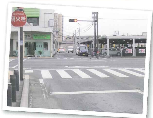
20年来の悲願であった国道10号線～御池都城線。出発点（鹿児島銀行付近）の拡張が決定し、いよいよ工事にかかります。萩原耕三議員とともに取り組んでまいりました。
