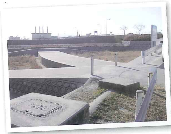
志比田町住宅供給公社建設の住宅 浸水防止の排水設備が完成
